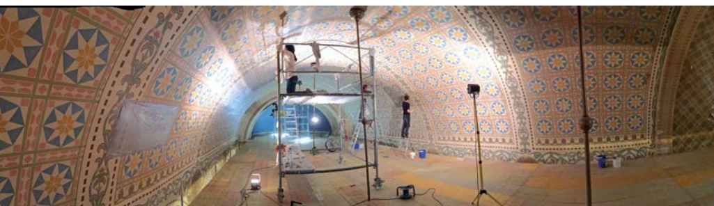
Vue panoramique de la partie supérieure de la nef de la Grande synagogue de Lausanne, en cours de nettoyage des peintures murales, travaux entrepris en 2015.
